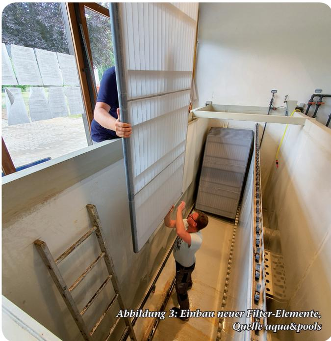
Abbildung 3: Einbau neuer Filter-Elemente, Quelle aqua&pools
