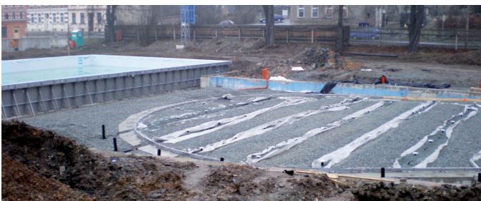
Foto 11: Reichenbach Erlebnisbecken, Verrohrung, aqua&pools
