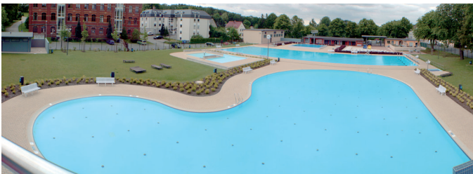
Foto 10: Reichenbach, Ausblick von der Rutsche, aqua&pools
