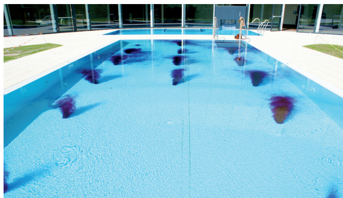
Foto 5: Einstromöffnungen am Beckenboden, aqua&pools
