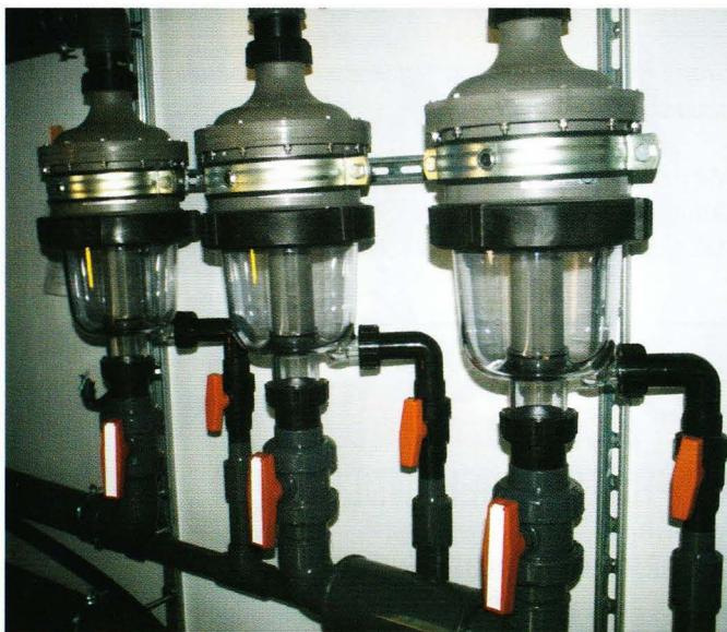
Foto 5: 3-fach Batterie Zyklonfilter, Neuinstallation, aqua&pools
