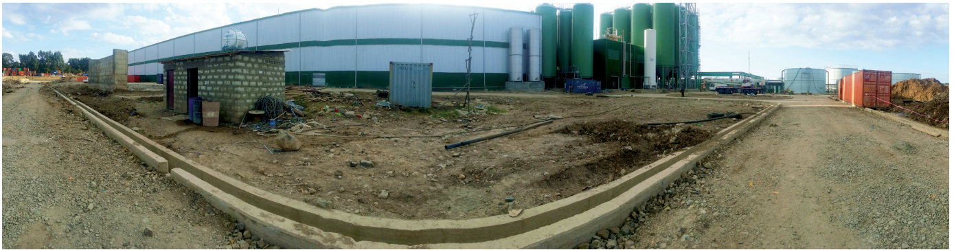
Foto 9: Baustelle der Brauerei in Debre Birhan, Äthiopien 2015, Quelle: aqua&pools · Mehr Infos dazu findet man auf den Referenzen der Webseite.
