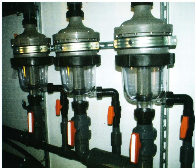
Foto 5: 3-fach Batterie Zyklonfilter, Neuinstallation, aqua&pools
